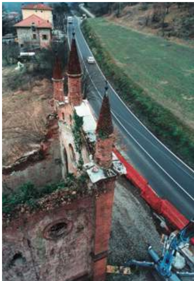
2. Vista della chiesa di San Giuseppe dal cestello utilizzato durante le fasi di rilevamento metrico
